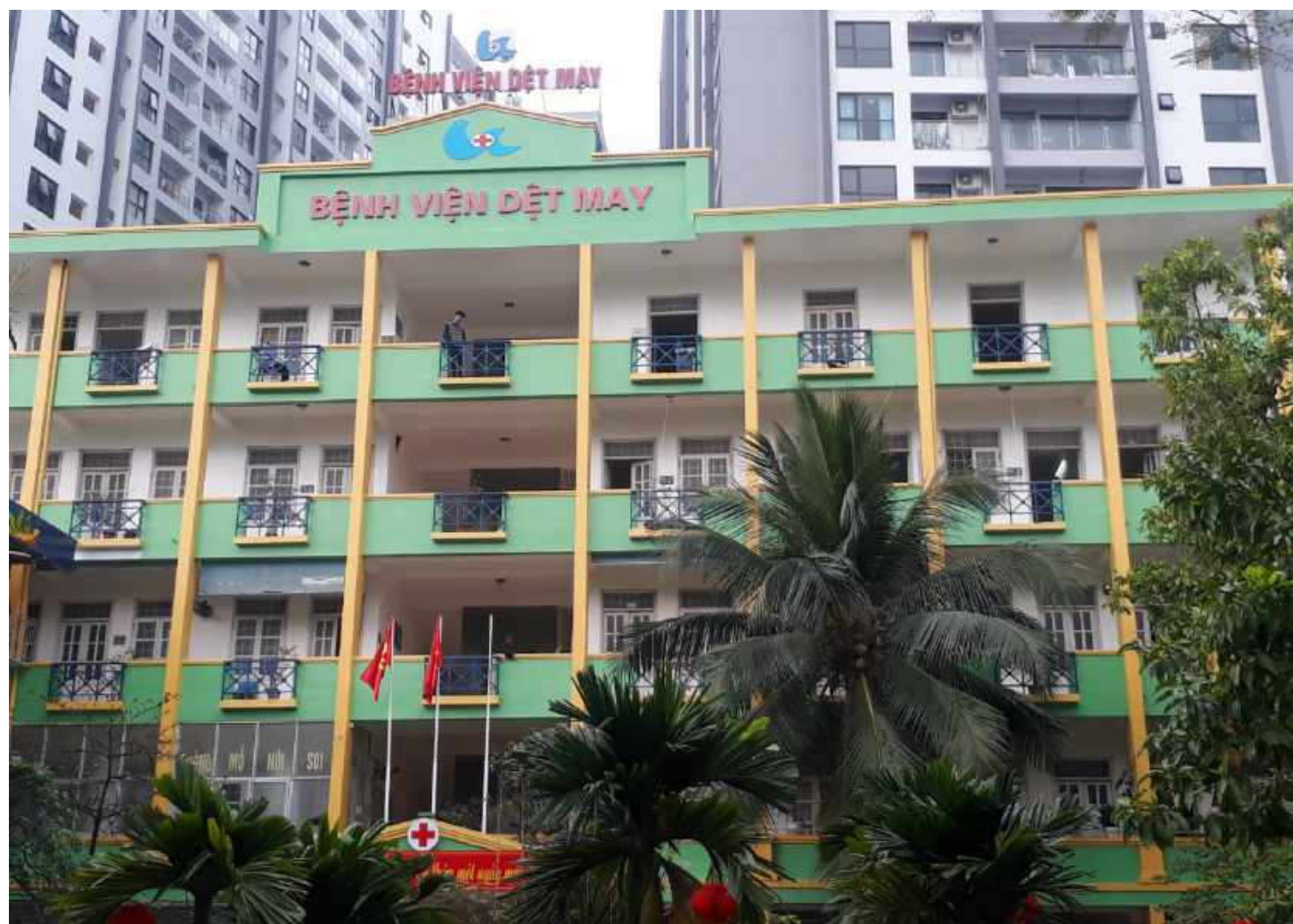
Công trình Sơn Bệnh Viện Dệt May
